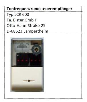
Die Funktion des Gerätes ist nur gegeben wenn eine individuelle Programmierung durchgeführt wurde. Die für die Programmierung notwendigen Daten sind abhängig vom Standort und der Einbindung ihrer Anlage in unserem Netz.
